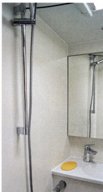
Für die Dusche gibt es einen separaten Raum vor dem Hauptschott.
