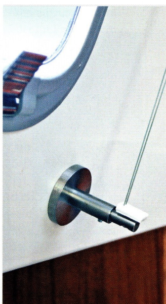
Schlecht: Die scharfkantigen Halterungen für die Plissees stehen in Kopfhöhe weit in den Raum.
