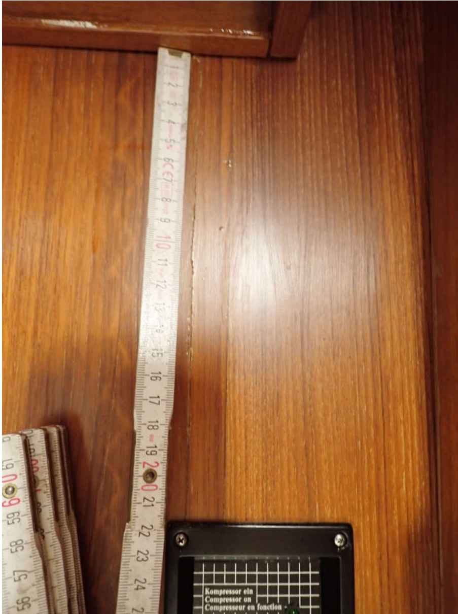
Der senkrechet Bruch des Pantryschotts auf der Stb.-Seite
