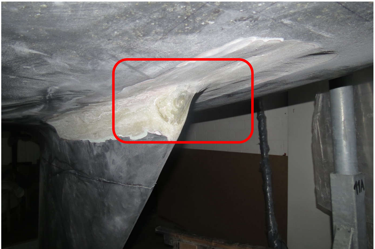
Nach den Schleifarbeiten austretende Feuchtigkeit aus dem Rumpflaminat an der Kielvorderkante.
