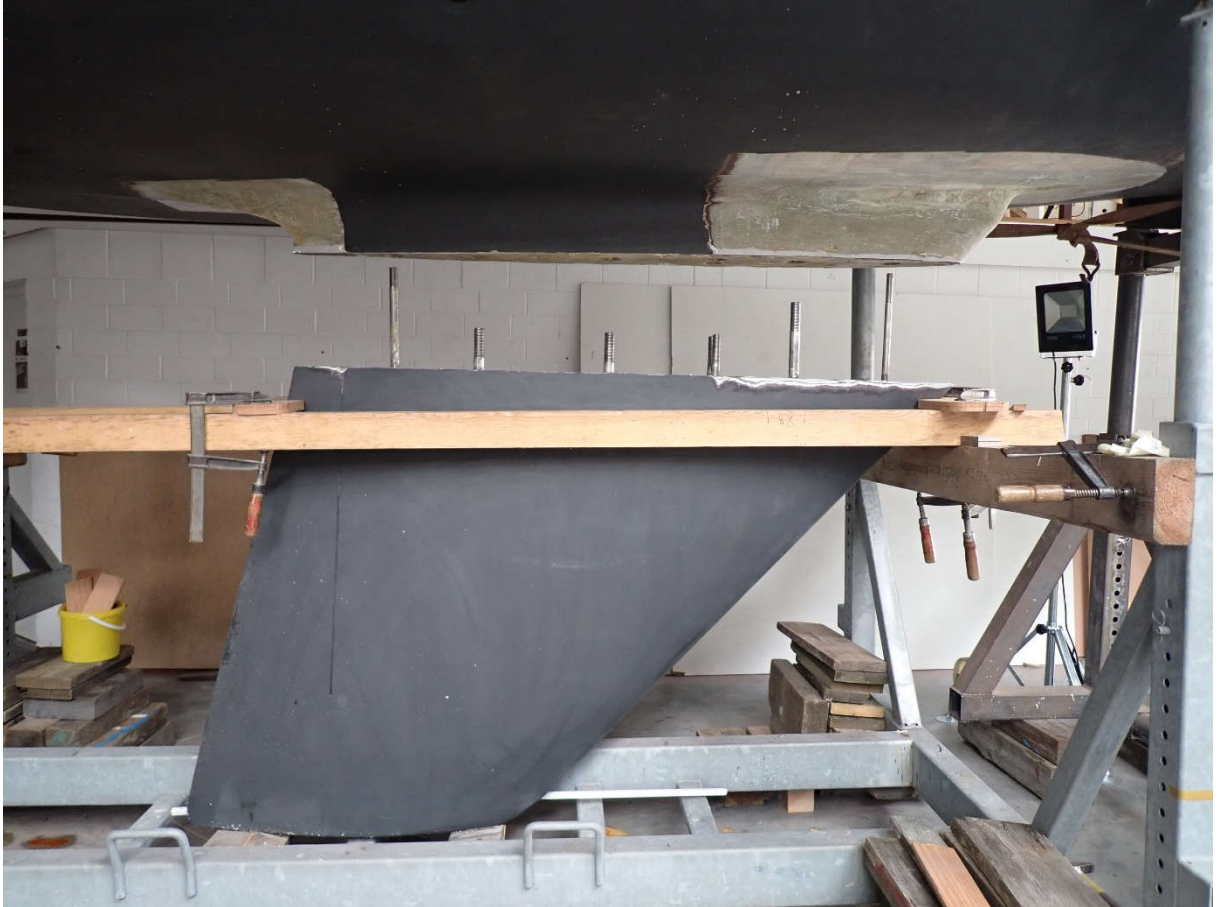
Zur Einordnung der Schadensbereiche. Der demontierte Kiel und die freigeschliffenen Bereiche im Rumpf, Unterwasserschiff.
