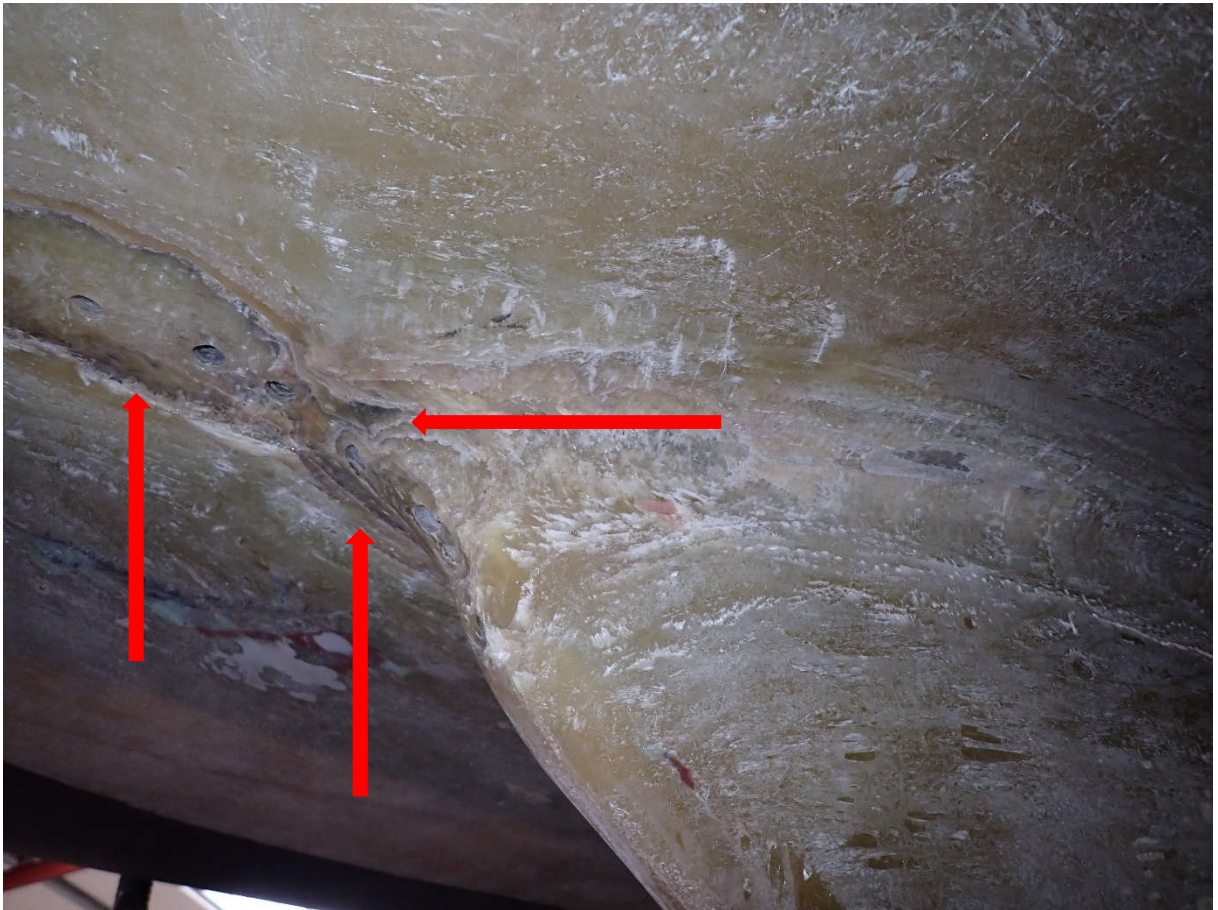
Wie zuvor, im Detail. Delamination im Rumpflaminat durch Fäulnis im Laminat.
