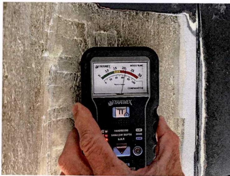
Feuchtigkeitsmessung im Bereich der Rumpfnah
